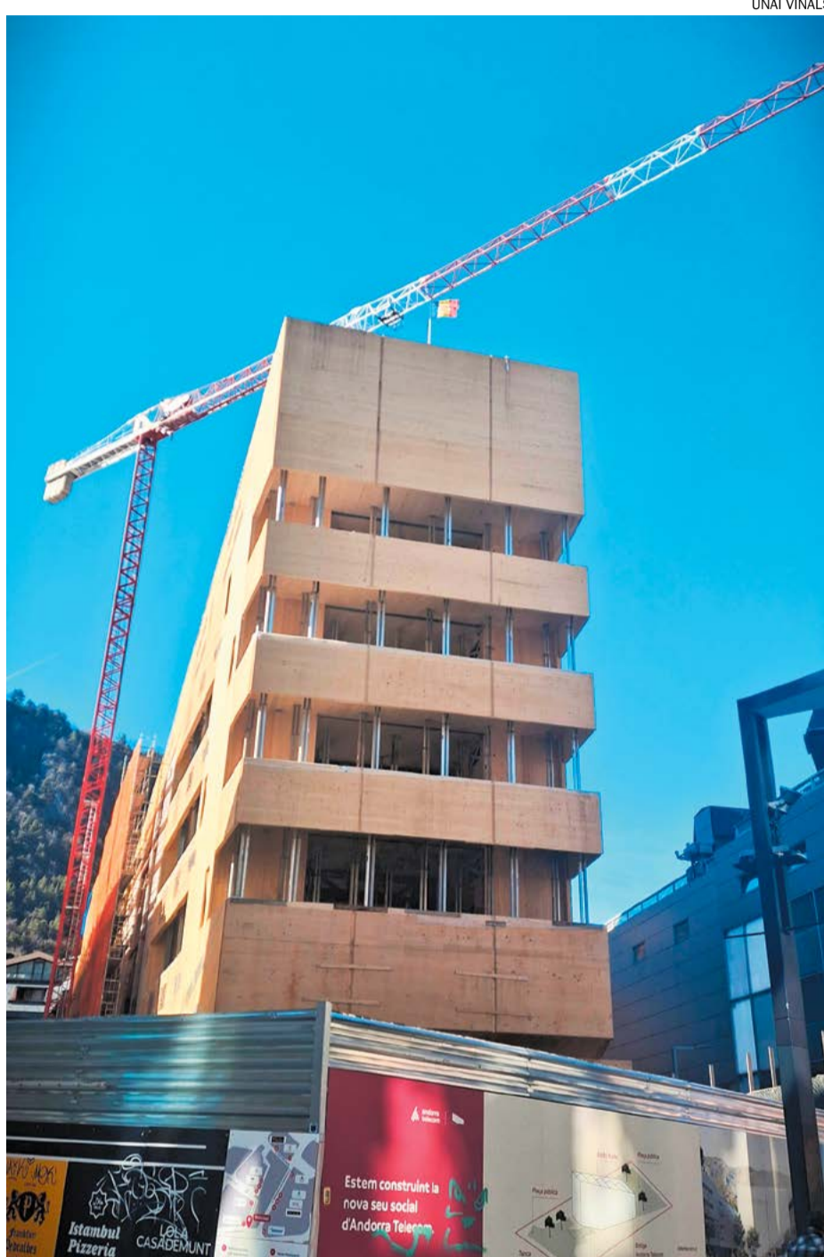
L'edifici Node, futura seu d'Andorra Telecom, amb una estructura totalment de fusta.
