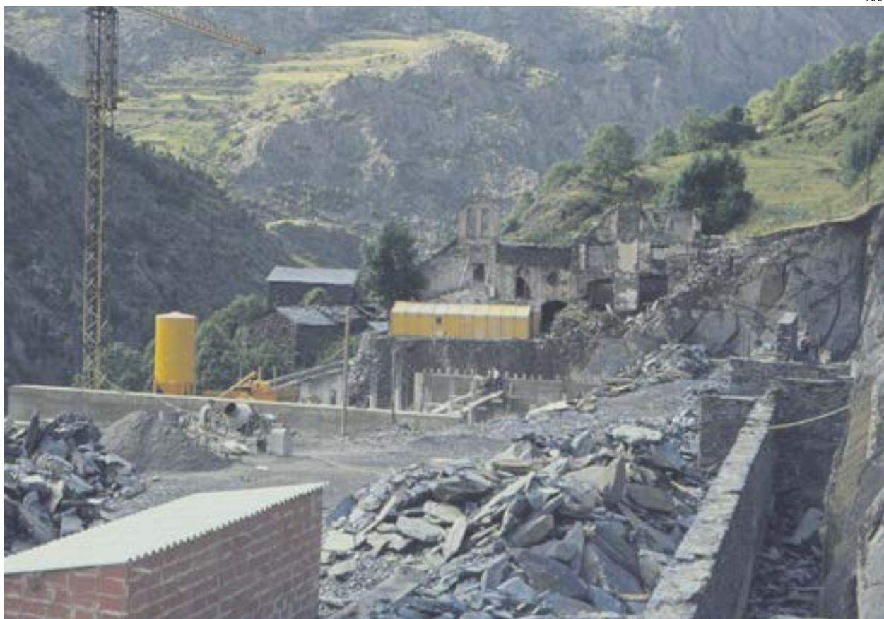
Construcció del nou Santuari de Meritxell.
