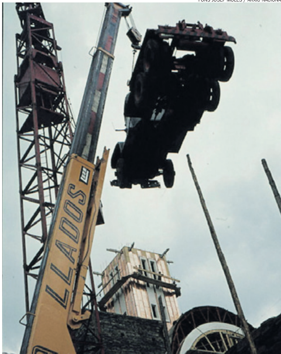
Imatge de la construcció del santuari de Meritxell, en el període 1973-1976.
