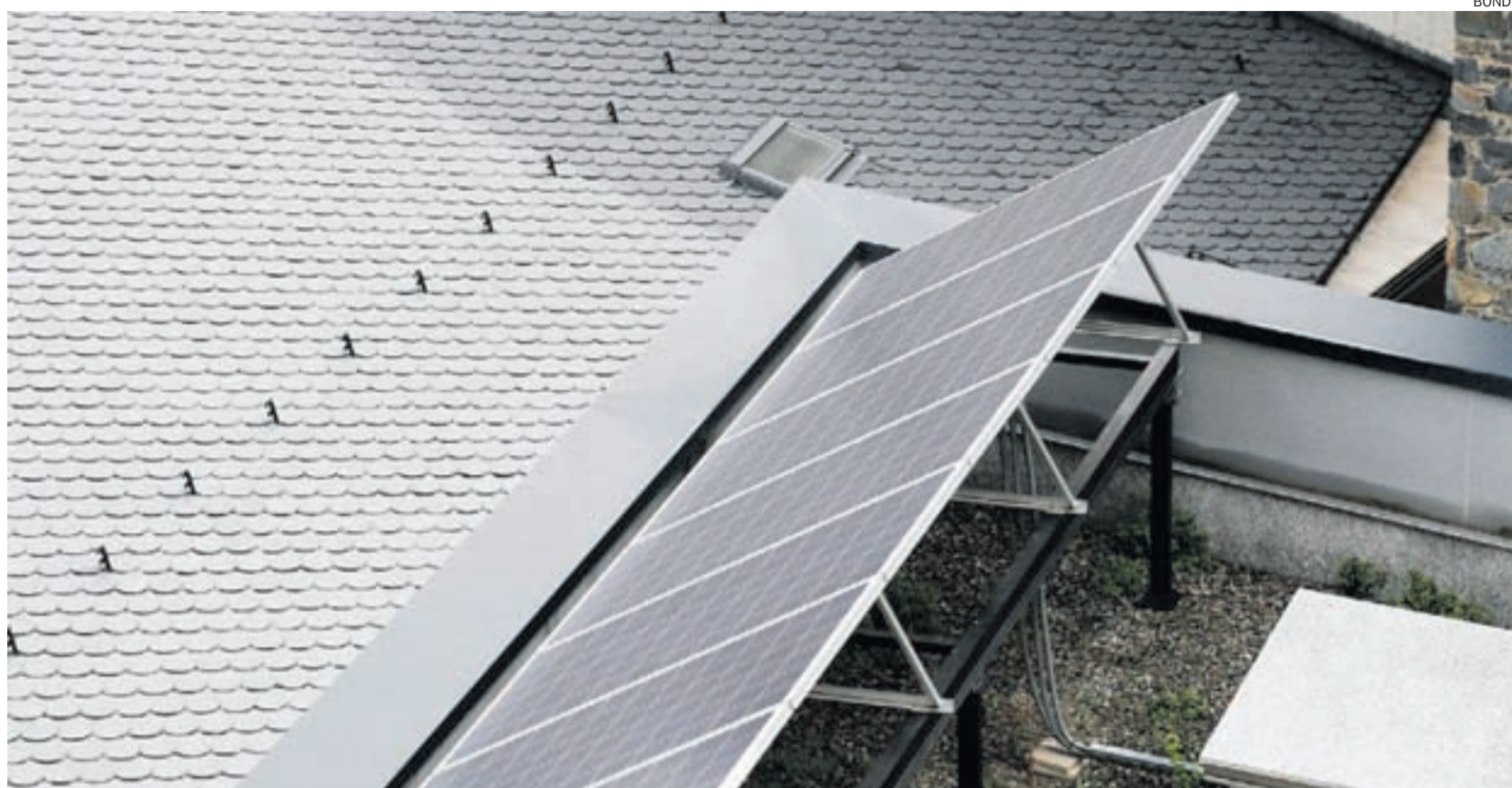
Plaques fotovoltaïques instal·lades a la coberta d'un edifici.
