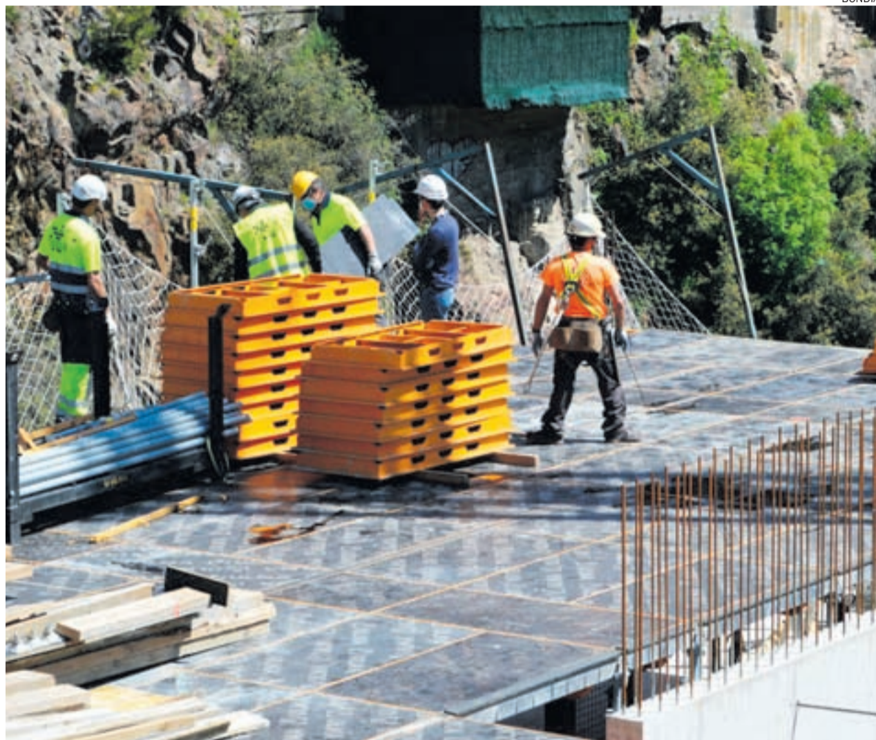
Treballadors en una obra.
