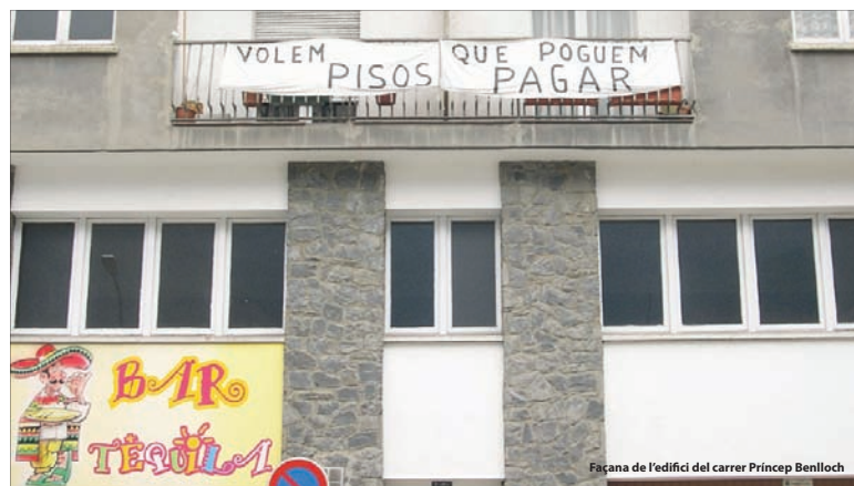
Façana de l'edifici del carrer Príncep Benlloch
